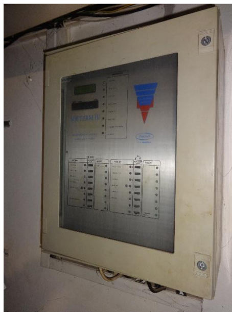
Obr. 6 Regulačný systém vykurovacieho systému.
