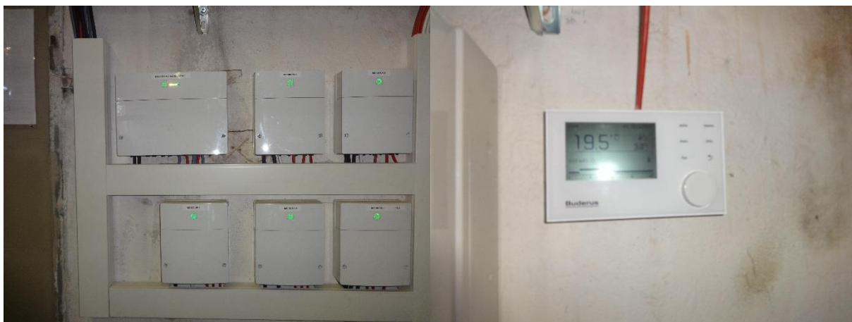
Obr. 2 Regulačný systém vykurovacieho systému.
