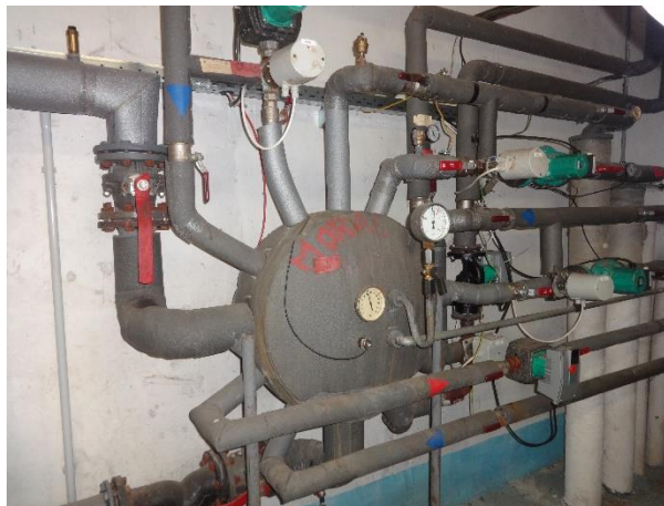
Obr. 1 Rozdeľovač a zberač vykurovacieho systému, sústava obehových čerpadiel a servoregulácie trojcestných ventilov teploty vody.
