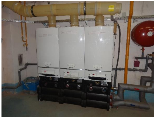
Obr. 1 Stacionárne plynové kotle Modratherm PKM 45S, Viessmann Vitodens 100, Karma Beta3
