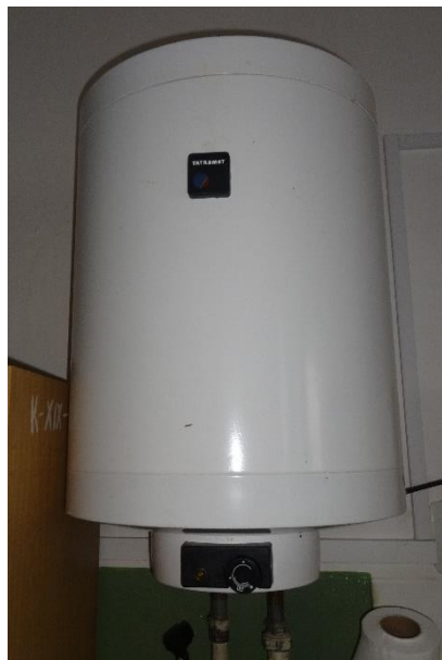
Obr. 2 Priamovýhrevný zásobníkový elektrický ohrievač teplej vody.
