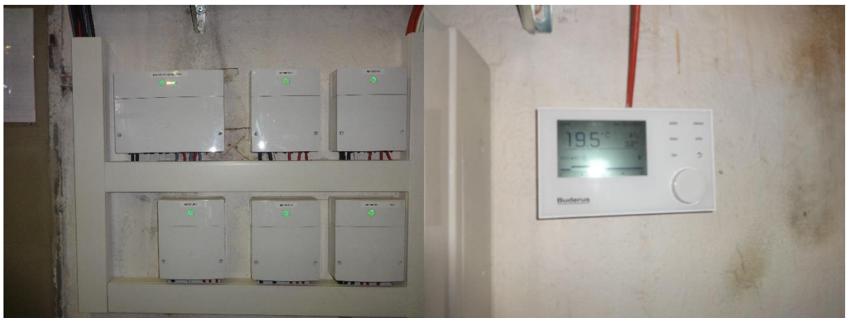
Obr. 2 Regulačný systém vykurovacieho systému.
