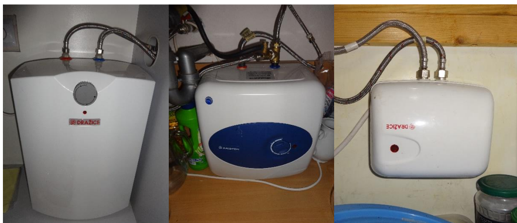
Obr. 4 Priamovýhrevné zásobníkové elektrické a prietokový ohrievače teplej vody.
