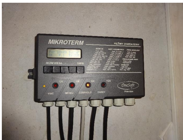
Obr. 6 Regulačný systém vykurovacieho systému.
