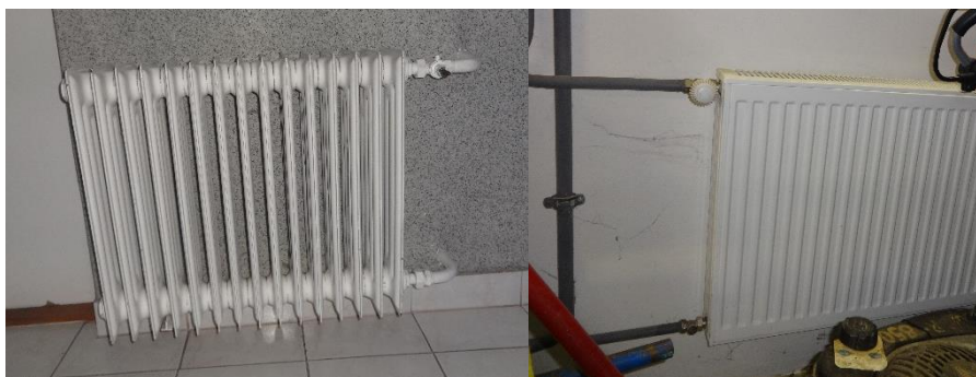
Obr. 7 Plechové rebrované a ocelové doskové vykurovacie telesá.
