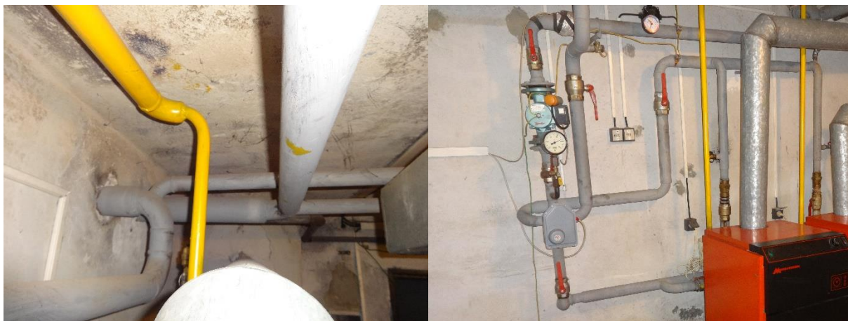
Obr. 5 Rozdelenie distribučného potrubia vykurovacieho systému na dve vetvy, sústava obehového čerpadla a regulácie teploty vody štvorcestným ventilom so servopohonom.
