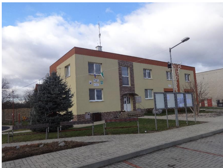
Obr. 2 Budova Obecného úradu Nitrica
