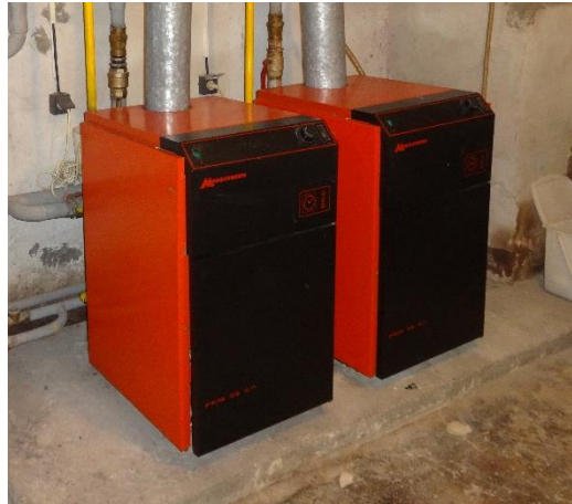
Obr. 3 Stacionárne plynové kotle Modratherm PKM 32S
